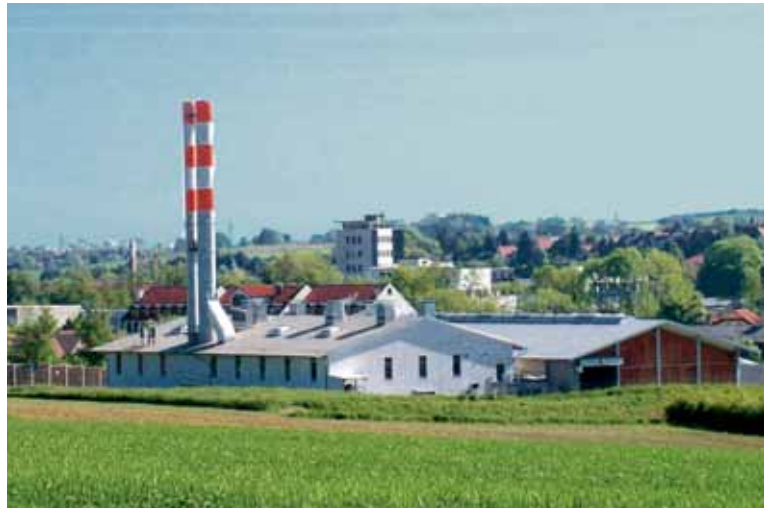
Das Biomasse-Heizkraftwerk in Pfaffenhofen.
